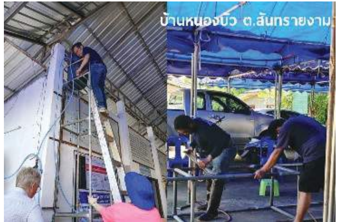
ติดตั้งระบบฉุกเฉินในพื้นที่ขาดแคลนน้ำ
